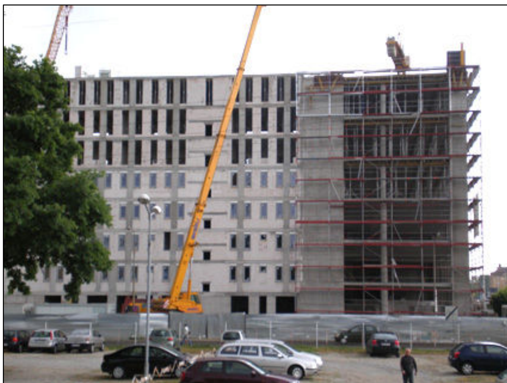
Przyszła siedziba OSK TAK (w budowie)
